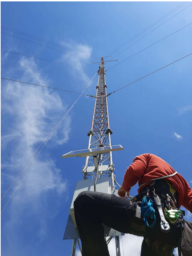
Mjerni stup za mjerenje vjetro potencijala
